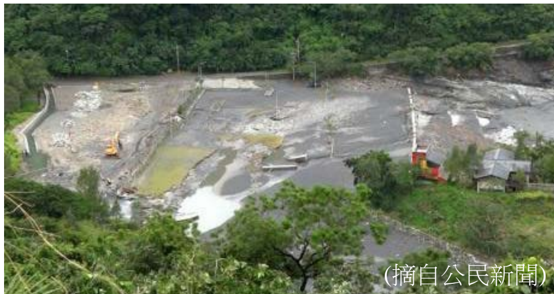
2013年天兔颱風後二度遭土石覆蓋， 八河局協助墊高基地與建設護堤
